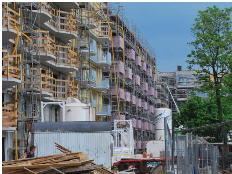
Bau der neuen Gemeinschaftswohnprojekte
