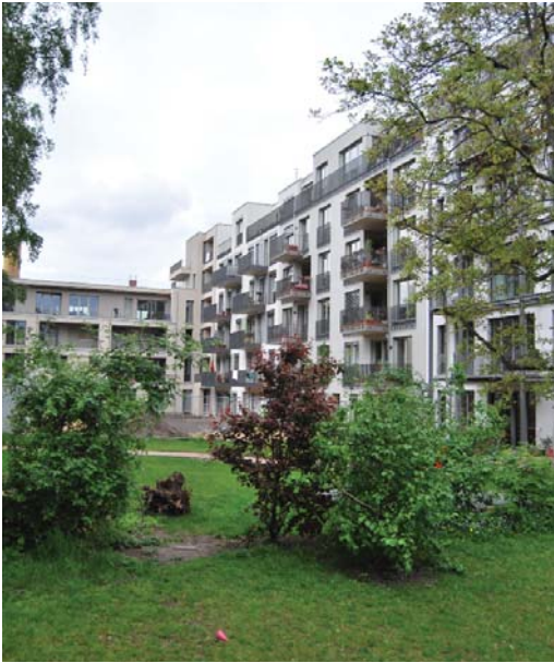
Baugruppenprojekte im Eschengraben
