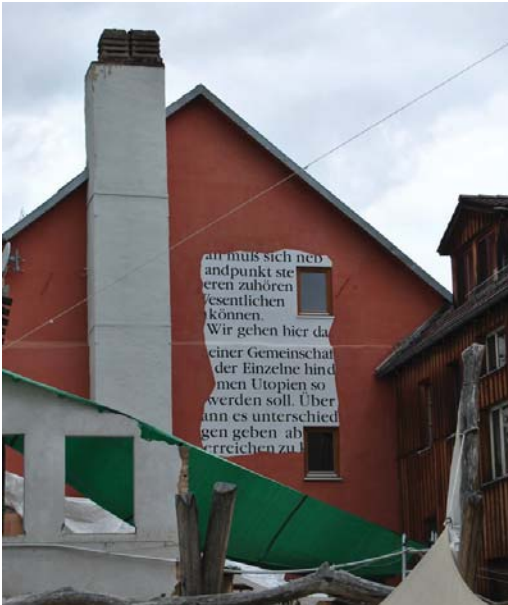
sanierte Fassade des Gemeinschaftshauses
