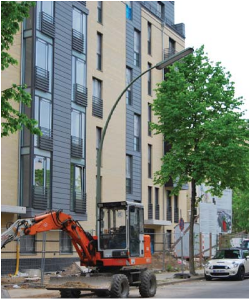
Neue Fassaden in der Schwiebusser Straße
