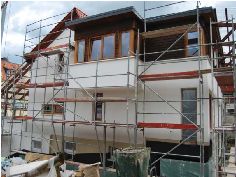
Neubau eines Doppelhauses
