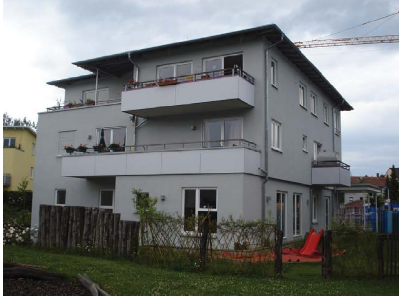
Leben und Arbeiten unter einem Dach
