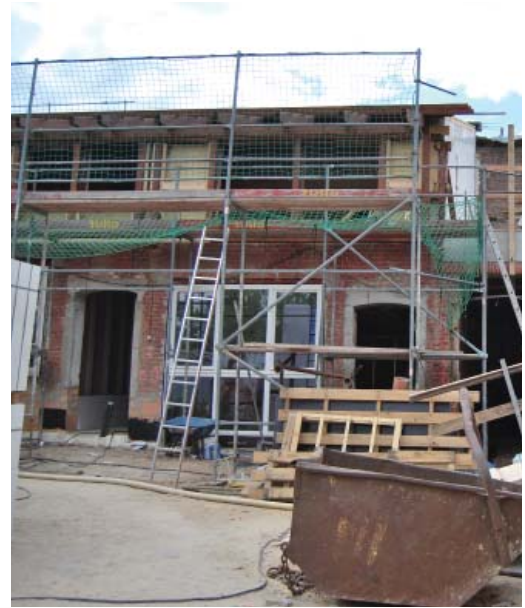
Umbau der Stallungen zu Wohnraum
