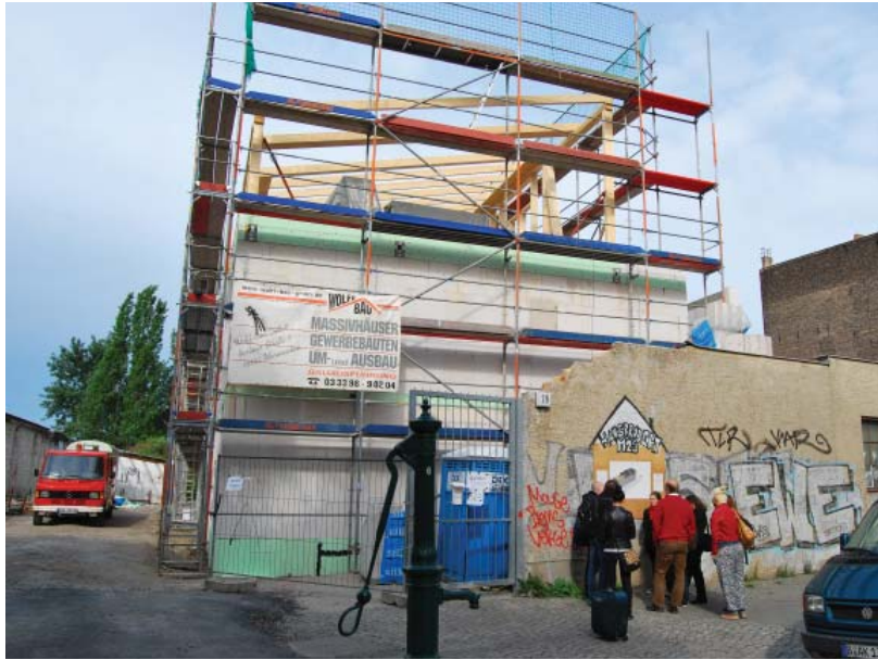
Hausprojekt im Bau
