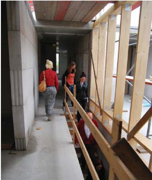
Hausprojekt im Bau
