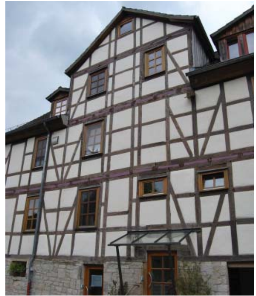
Fachwerkfassade des Tagungshauses
