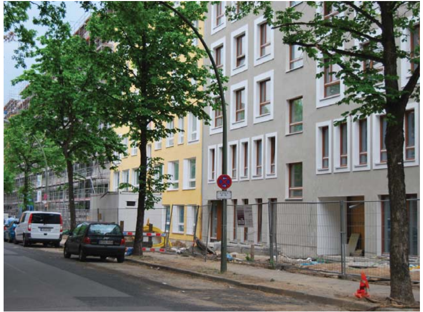
Neue Fassaden in der Schwiebusser Straße
