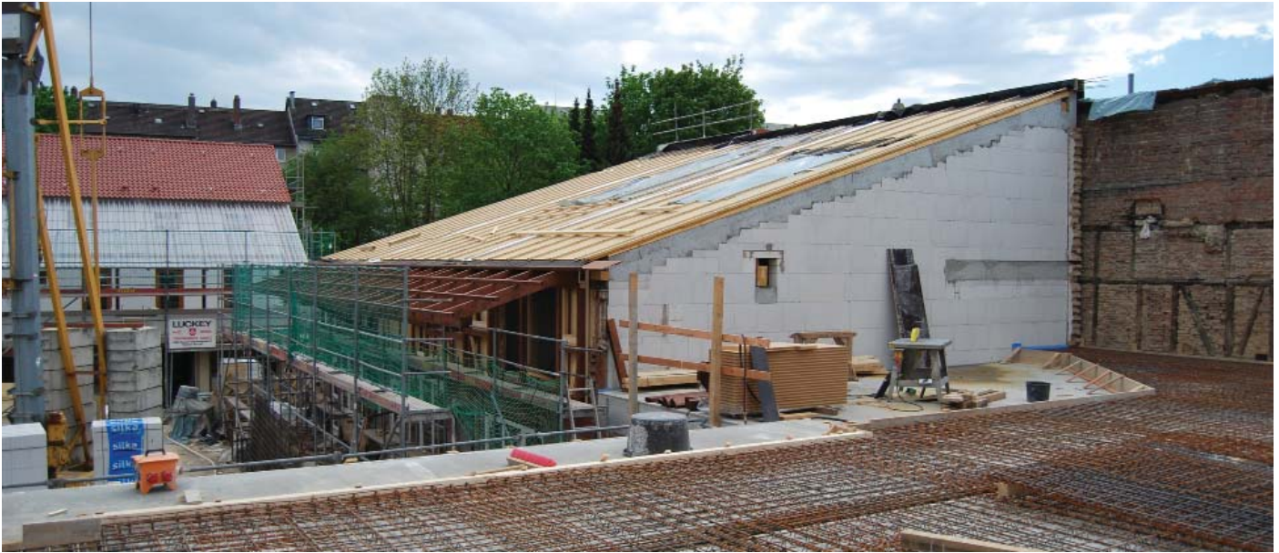
Umbau der Stallungen und der Scheune
