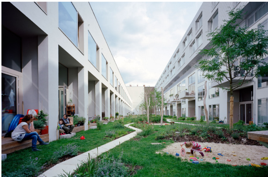
zwischen Vorderhaus- und Hinterhauszeile
