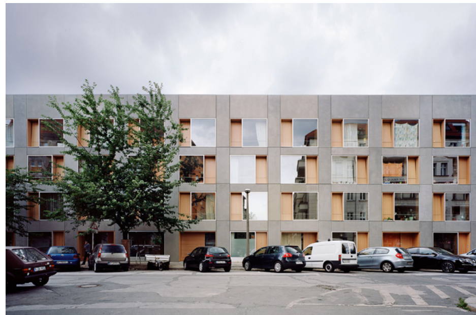
Straßenfassade, Fotos: Simon Menges
